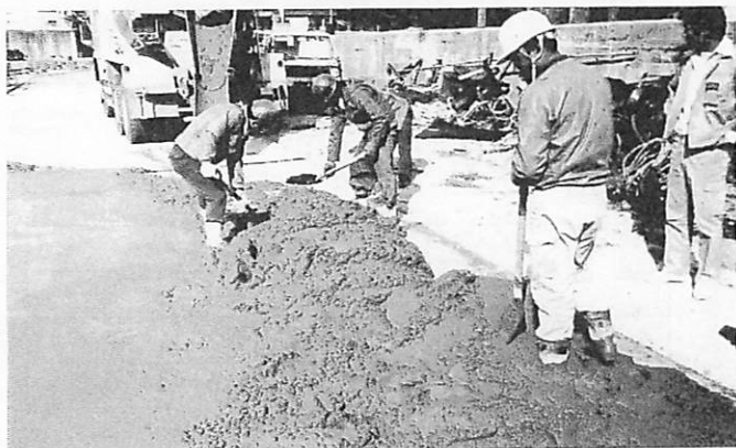
▲スクリーデックスを混和した生モルタル(1:4)が到着
